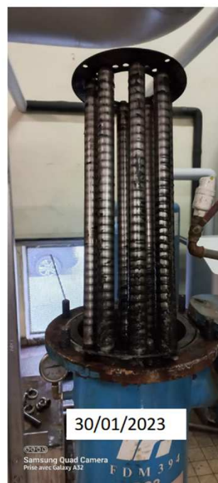
Réseau de Chaleur Quartier Grand Estressin Vienne Condrieu Agglomération - (38)
