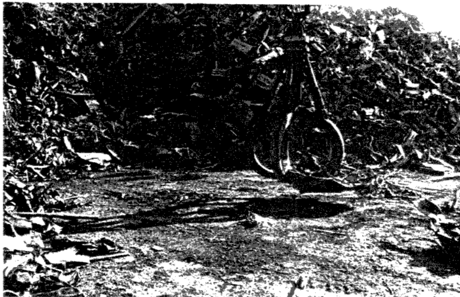
Figura 3 – Isolamento da fonte radioactiva já detectada
